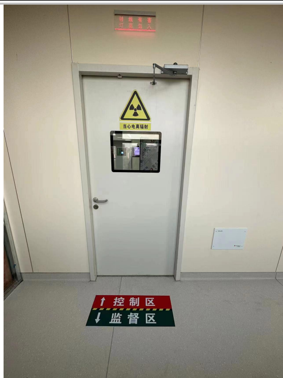
医疗综合楼四楼复合手术室污物通道防护门、警告标志、工作指示灯、闭门装置等
